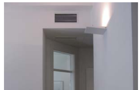
Kanalgerät dezent in Gebäudestruktur integriert
